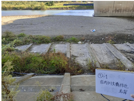
⑦庄内川大橋付近
