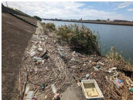
新川（③-2_日の出橋付近_左岸）
