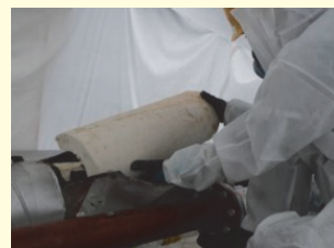
新たに作業基準が設けられた石綿含有成形板等の除去等の様子
