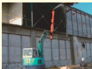
新たに作業基準が設けられた石綿含有成形板等の除去等の様子
