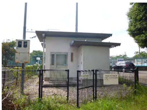
大気汚染測定局の外観
