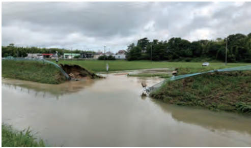
はんば 堤防が決壊した半場川（安城市）
