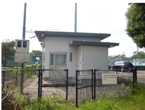
大気汚染常時監視測定局の外観
