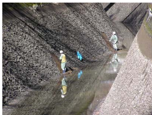
導水路での削ぎ落とし作業
