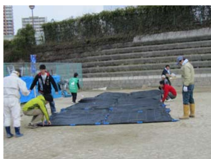
遮光シートのつなぎ合わせ作業
