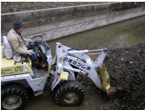
カワヒバリガイの除去作業 (枝下用水：豊田市)
