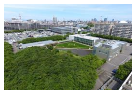
工場跡地を利用したビオトープ
