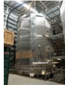
Barwon Waterの建設中の乾燥施設
