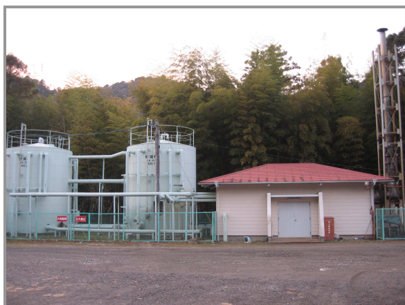
Fig.24 湯谷温泉配湯所施設
