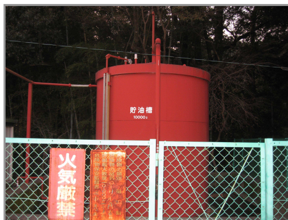
Fig.25 湯谷温泉配湯所施設重油タンク
