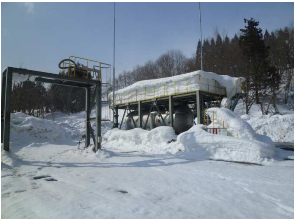
⑦ タール貯蔵タンク
