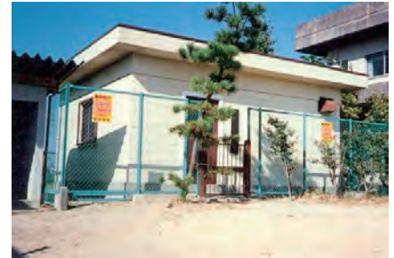
図 7-2-2 地盤沈下観測所
