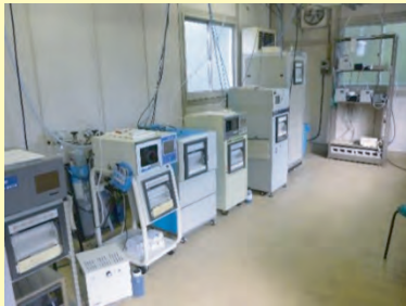
大気汚染常時監視測定局の内部
