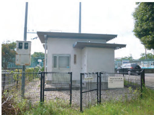
大気汚染常時監視測定局の外観
