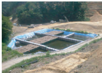
仮設沈砂池設置による排水対策
