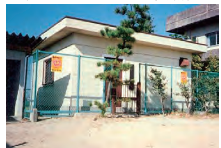
図7-2-2 地盤沈下観測所
