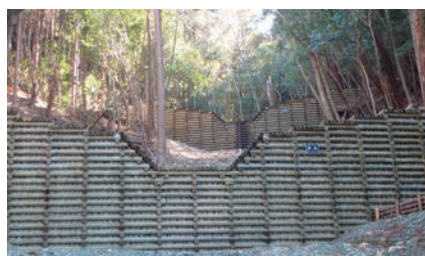
治山事業（新城市 溪間工）
