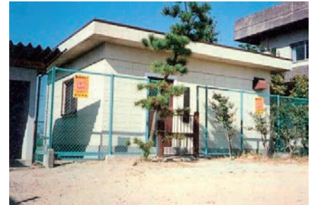
図7-2-2 地盤沈下観測所
