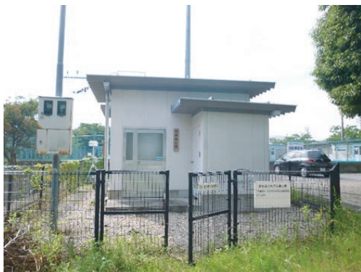
大気汚染常時監視測定局の外観
