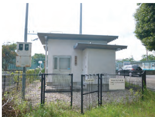
大気汚染常時監視測定局の外観
