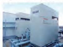
ガスエンジンにより発電し、その際発生する熱を捨てずに温水として空調システムの熱源として利用
