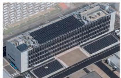
発電効率の高い単結晶型太陽光発電パネルを本施設の屋上と地上、南外壁面の一部に敷設。また、南外壁面の一部には、シーソー型太陽光発電パネルを採用しており、発電量を確保しつつ、眺望や採光、デザイン性にも配慮
