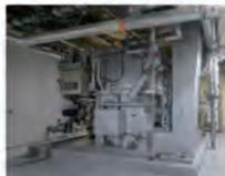
太陽熱とガスマイクロコージェネレーションの2種類の廃温水を1台で同時に回収可能
