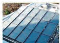
太陽熱集熱器により温められた温水を空調システムの熱源として利用
