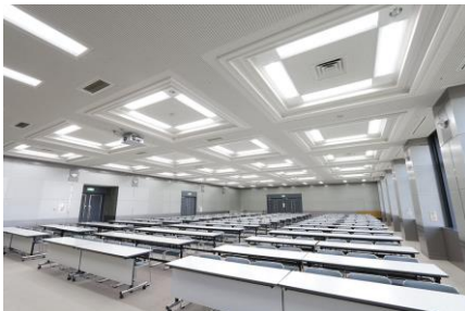
LED 照明を導入した庁舎（西三河総合庁舎）
