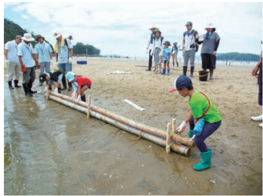
砂の流出防止柵を設置する参加者 (三河湾環境再生体験会)
