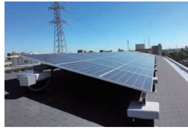
太陽光発電 (名古屋市・県営千年住宅)
