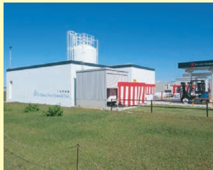
設備全景とフォークリフト
