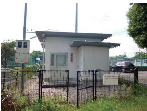
大気汚染常時監視測定局の外観
