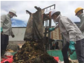
廃棄物撤去の様子
