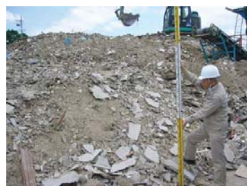
立入検査の状況
