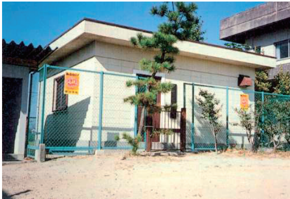
図 7-2-2 地盤沈下観測所
