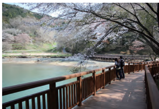
水環境整備事業 重川池地区（新城市）
