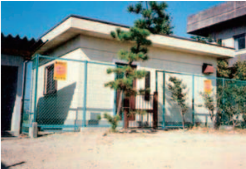
図2-7-4 地盤沈下観測所
