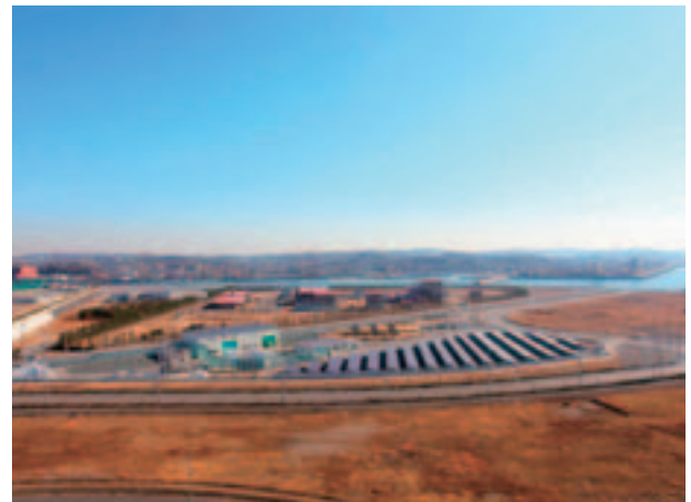
あいち臨空新エネルギー実証研究エリア全景
